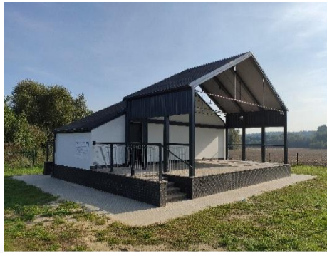
Gmina Szydłowo „Budowa infrastruktury rekreacyjnej - Budowa sceny plenerowej z zapleczem gospodarczym w Tarnowie”
